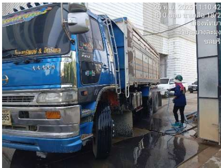
รูปที่ 10 การล้างล้อรถเข้า - ออกโครงการ
