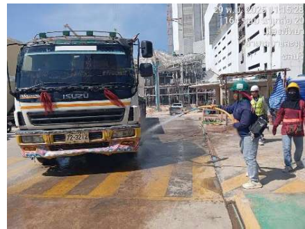
รูปที่ 10 การล้างล้อรถเข้า - ออกโครงการ
